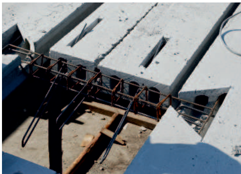
Zamontowanie zbrojenia wymianu w kanałach płyt.
